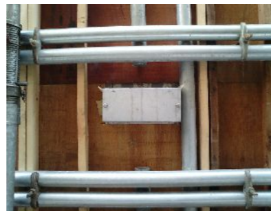
ボス型枠設置
