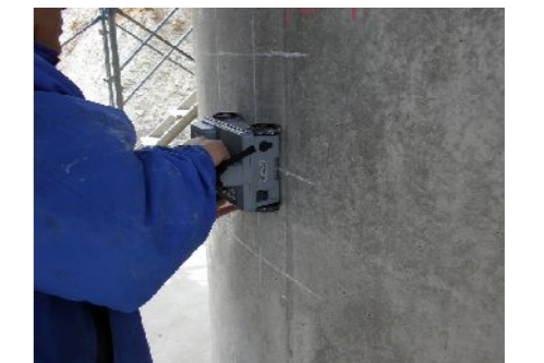
鉄筋探査状況（位置測定）
